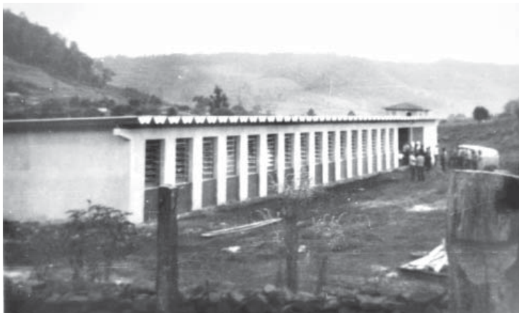
Figura 10 - Vista externa parcial da Escola Básica Rui Barbosa [19--]
