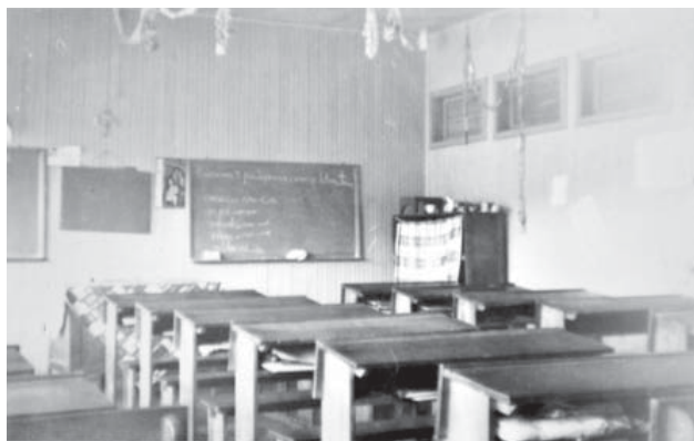
Figura 9 - Vista interna de sala de aula da Escola Básica Rui Barbosa [19--]
