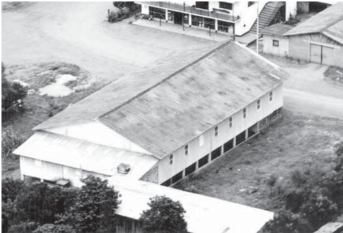
Figura 40 – Vista externa parcial do Salão da Sociedade Esportiva e Recreativa Formosa [19--]
