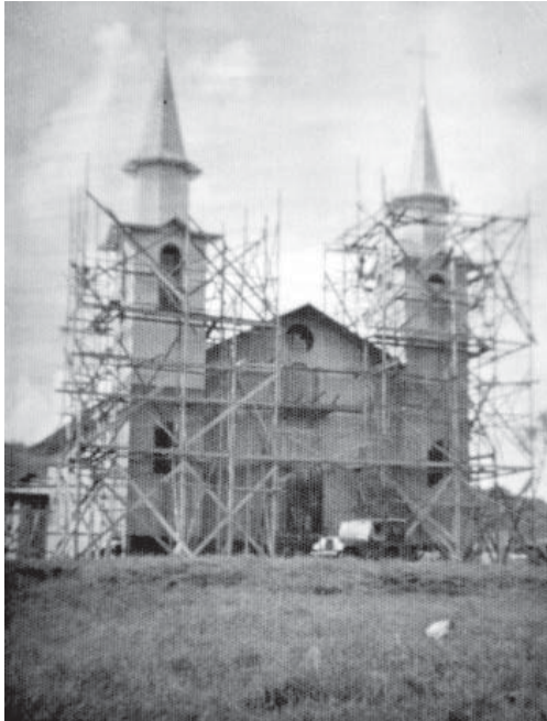
Figura 12 - Pintura da Capela São Cristóvão (09 jul. 1965)
