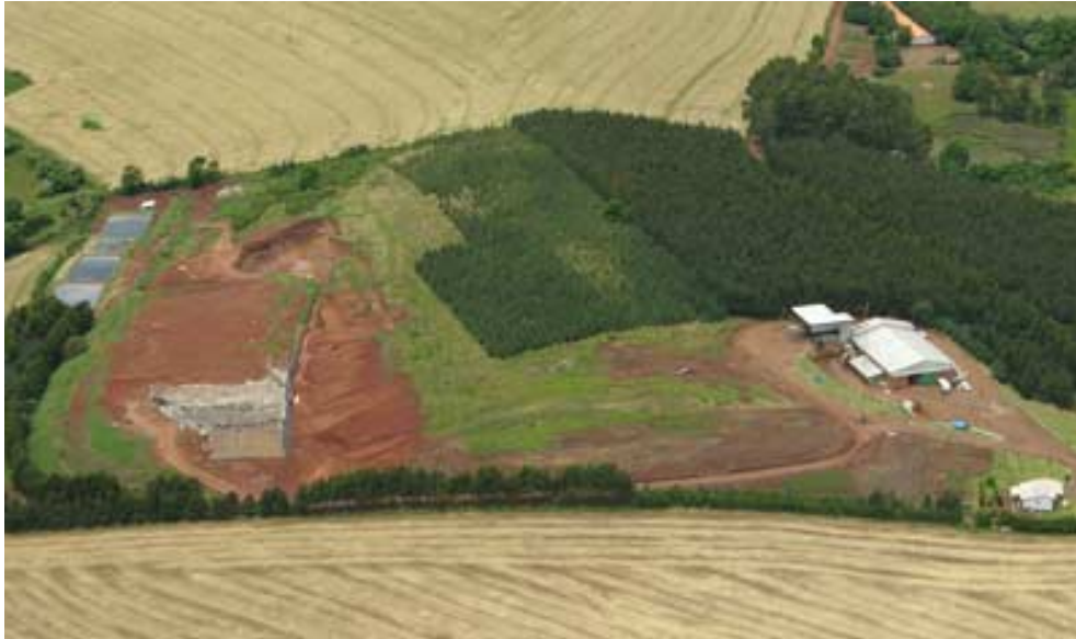
Figura 10.14 - Aterro Sanitário da empresa CONTINENTAL em Xanxerê – SC
