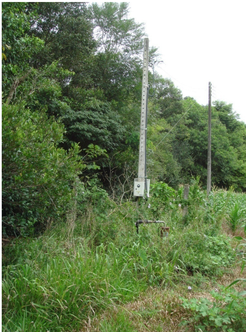
Figura 8.1- - Poço profundo - alimentação de cinco bicas Fonte: Consórcio MPB/ESSE/SANETAL
