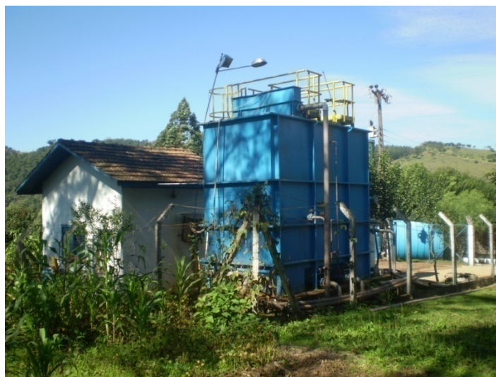
Figura 8.4 - ETA (Metálica) no município de Formosa do Sul
