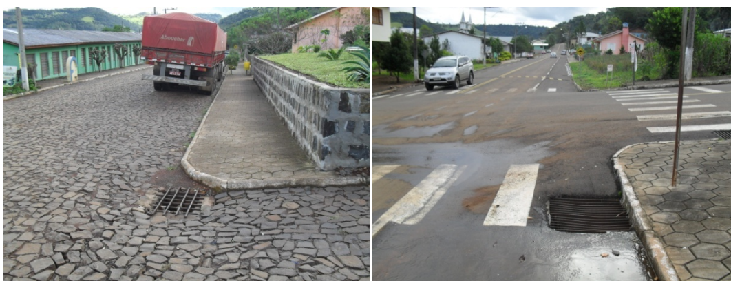
Figura 9.7 e 9.8 – Bocas de Lobo Fonte: Consórcio MPB/ESSE/SANETAL
