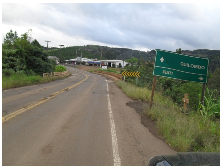
Figura 9.6 – Ponte sobre o rio João Emílio
