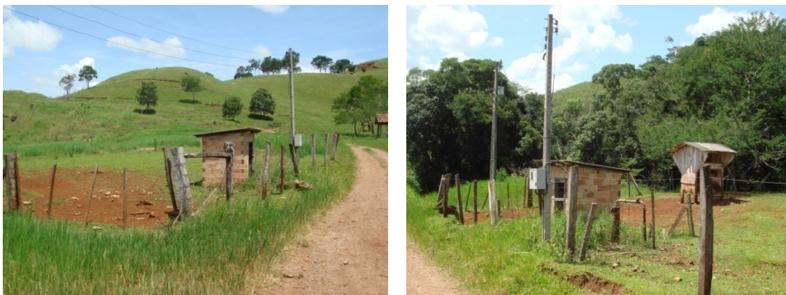
Figura 8.7 e 8.8 – Poço profundo – linha Segalin
