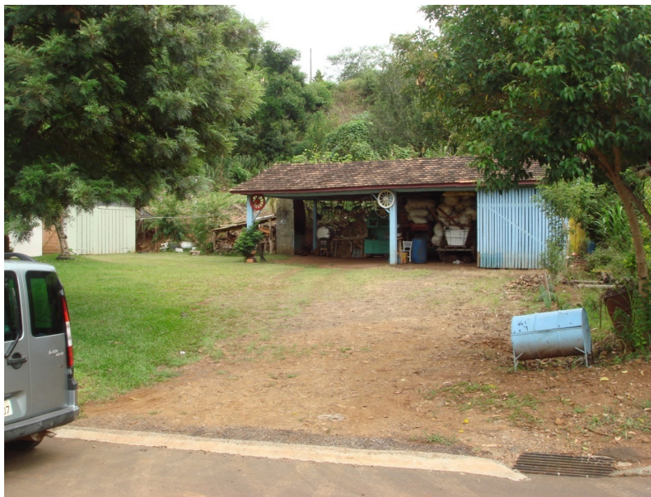
Figura 10.4 – Barracão de depósito de lixo reciclável (catadores)
