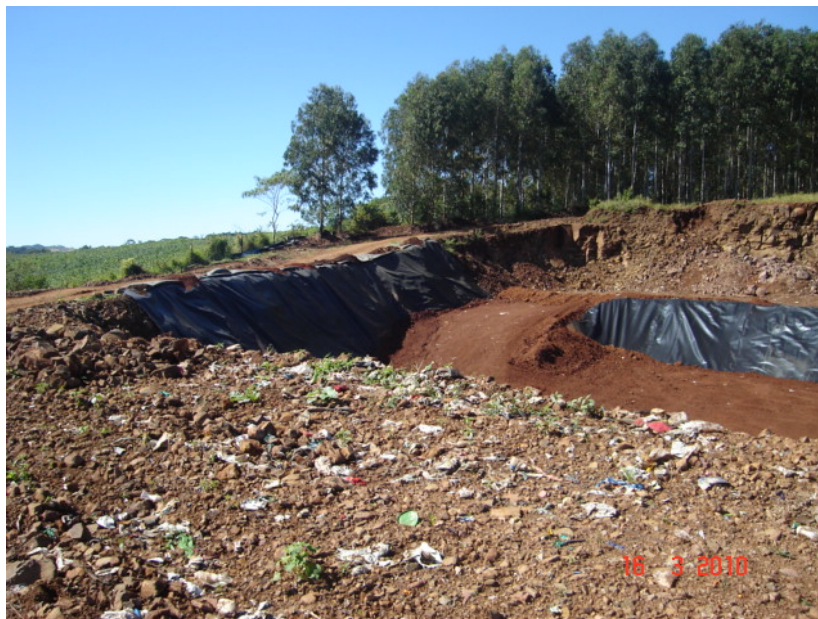
Figura 10.20 - Aterro Sanitário da empresa CONTINENTAL em Xanxere – SC Disposição Final
